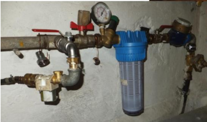
Elektromagnetický ventil na privode vody
