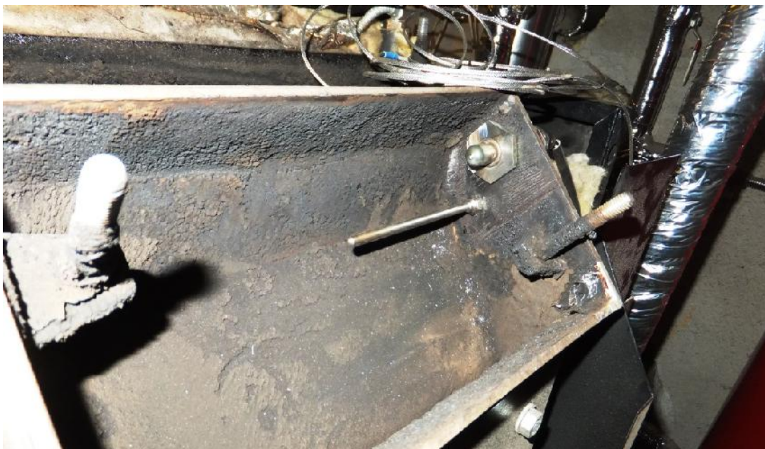
Obrázok 14: Lambda sonda spolu s termočlánkom umiestnené v dymovode kotla
