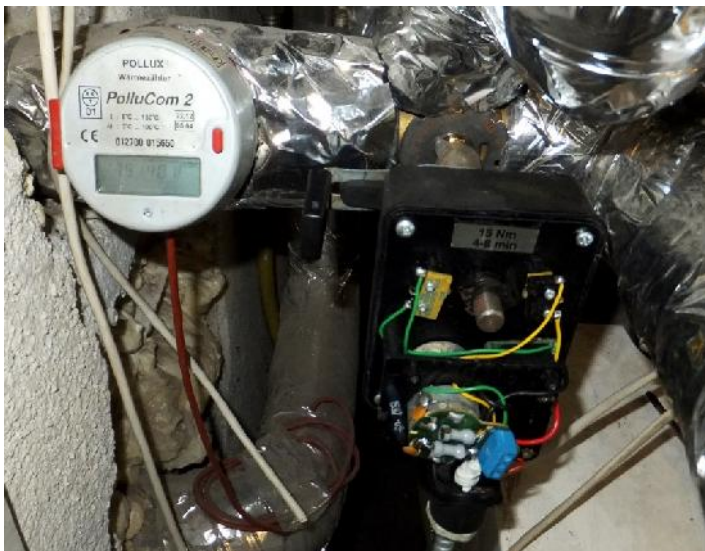
Obrázok 3: Servo na zmiešavacom ventile, merač spotreby tepla
