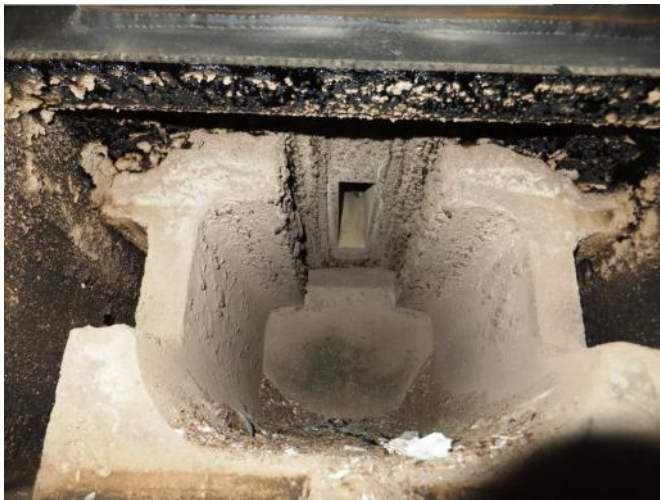
Termočlánok v spaľovacej komore so žiaruvzdorného betónu, teplota sa môže vyšplhať až na 1100 °C
