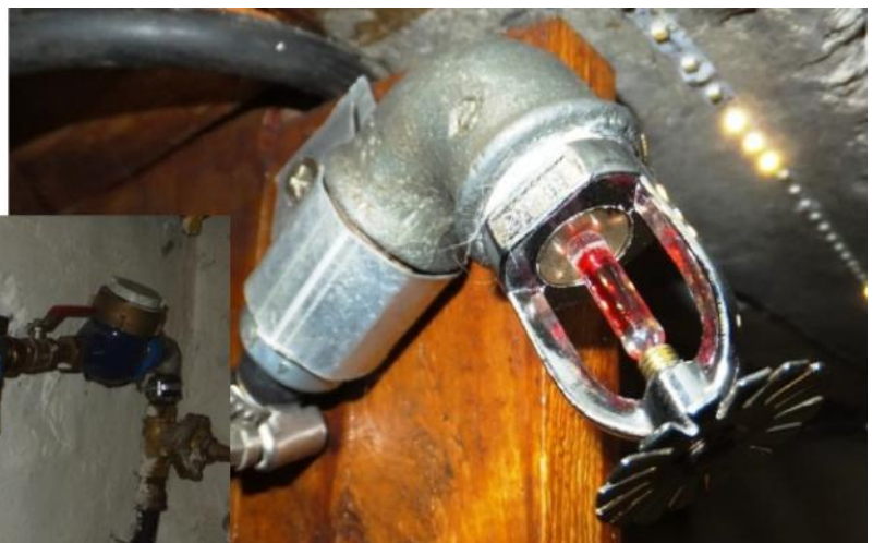
Sprinklerová hlavica na automatické hasenie v prípade požiaru ( banka praskne pri 68 °C)
