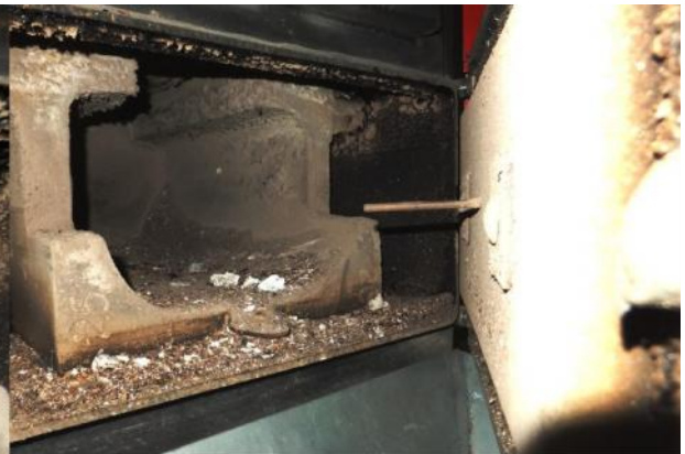
Termočlánok v spaľovacej komore so žiaruvzdorného betónu, teplota sa môže vyšplhať až na 1100 °C
